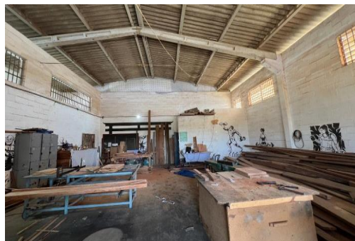
Foto 38: Imóvel vistoriado - OFICINA 1.
