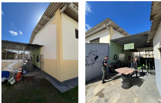
Foto 17 e 18: Imóvel vistoriado - FUNDOS DO GALPÃO
