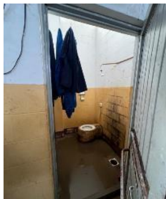
Foto 30: Banheiro - Imóvel vistoriado - OFICINA 2.
