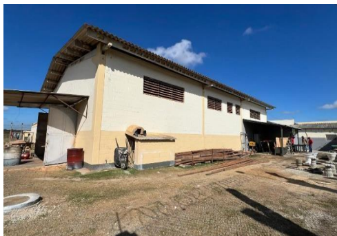
Foto 13: Imóvel vistoriado - LATERAL DIREITA
