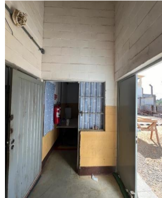
Foto 21: Imóvel vistoriado - CIRCULAÇÃO DE ENTRADA.
