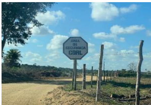
Foto 1: VIA DE TERRA DE ACESSO A CDRL.
