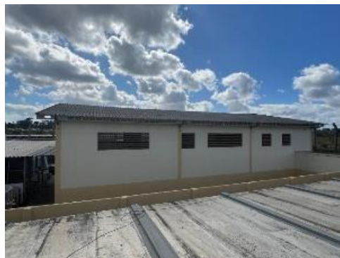
Foto 16: Imóvel vistoriado - LATERAL ESQUERDA
