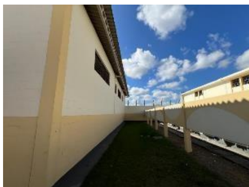
Foto 15: Imóvel vistoriado - LATERAL ESQUERDA.
