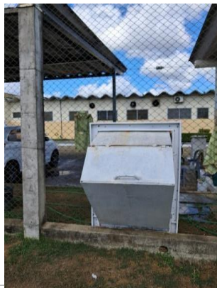
Foto 9: DEPÓSITO DE LIXO HOSPITALAR.
