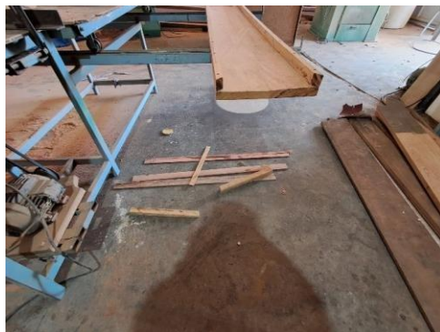
Foto 39: Imóvel vistoriado - PISO - OFICINA 1.
