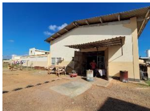
Foto 12: Imóvel vistoriado - FRENTE DO GALPÃO.
