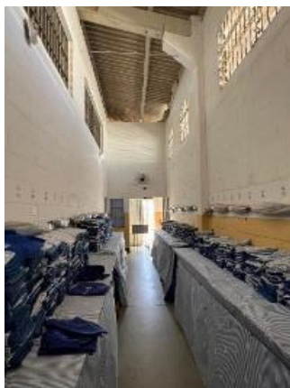
Foto 26: Imóvel vistoriado - CORREDOR DE ENTRADA DAS
