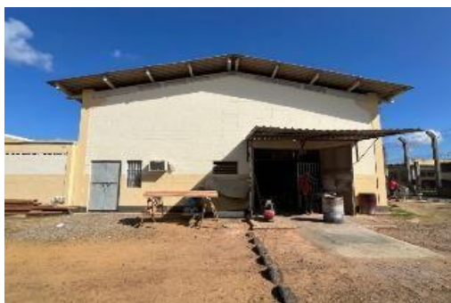
Foto 11: Imóvel vistoriado - FRENTE DO GALPÃO.
