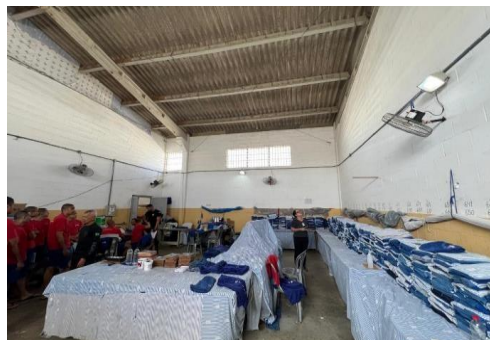
Foto 33: Imóvel vistoriado - COBERTURA - OFICINA 2.
