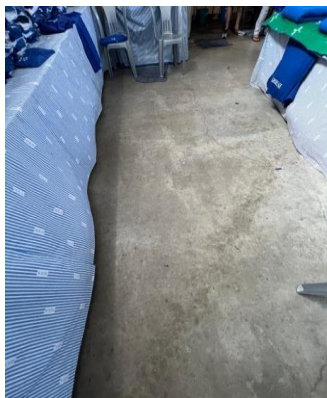
Foto 32: Imóvel vistoriado - PISO - OFICINA 2.
