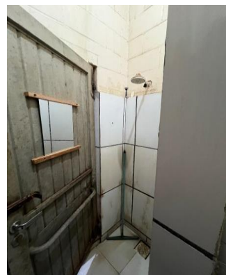
Foto 43: SANITÁRIO - BANHEIRO - OFICINA 1.
