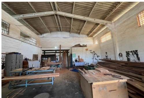
Foto 38: Imóvel vistoriado - OFICINA 1.
