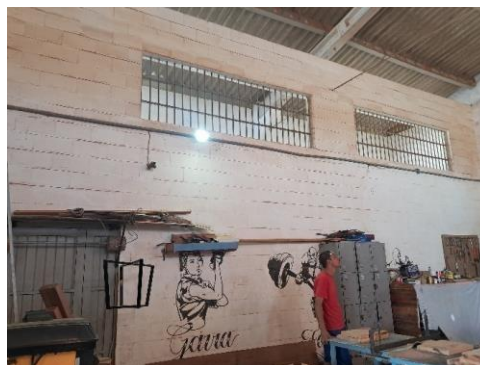
Foto 37: Imóvel vistoriado - VENTILAÇÃO - OFICINA 1.
