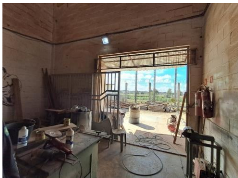
Foto 36: Imóvel vistoriado - PORTÃO DE ENTRADA - OFICINA 1.
