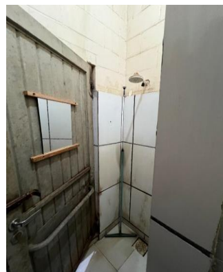
Foto 43: SANITÁRIO - BANHEIRO - OFICINA 1.
