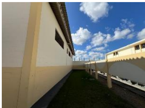
Foto 15: Imóvel vistoriado - LATERAL ESQUERDA.
