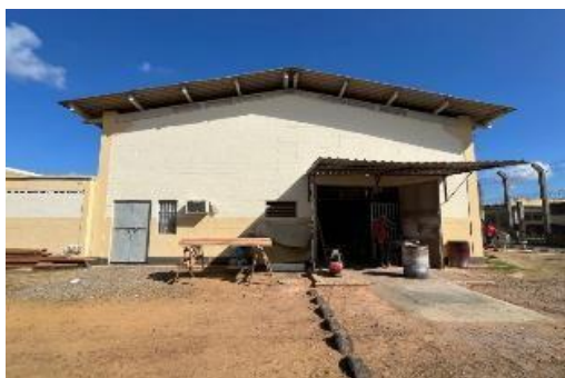
Foto 11: Imóvel vistoriado - FRENTE DO GALPÃO.
