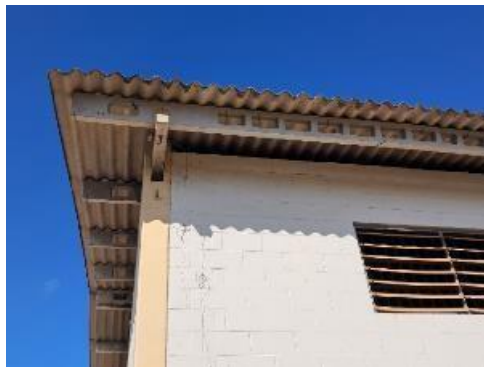
Foto 19: Imóvel vistoriado - DETALHE COBERTURA
