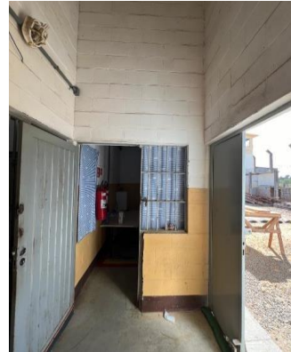
Foto 21: Imóvel vistoriado - CIRCULAÇÃO DE ENTRADA.
