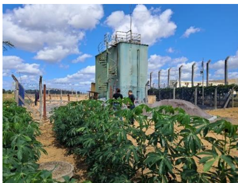
Foto 8: ESTAÇÃO DE TRATAMENTO DE ESGOTO.
