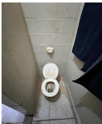
Foto 42: Imóvel vistoriado - BANHEIRO - OFICINA 1.
