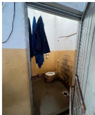
Foto 30: Banheiro - Imóvel vistoriado - OFICINA 2.
