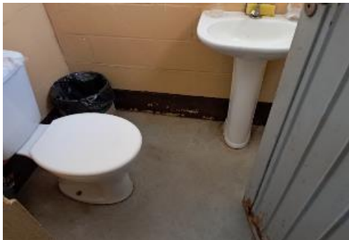
Foto 24: Imóvel vistoriado -BANHEIROS DA S. DE CONTROLE
