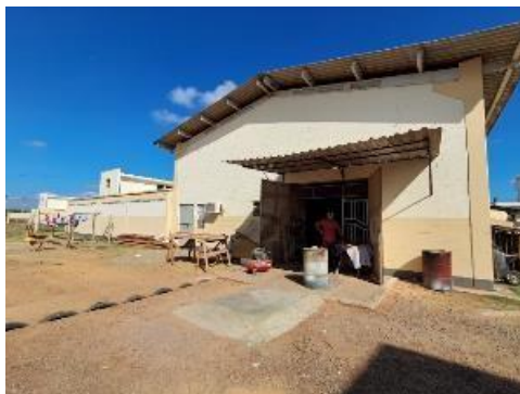
Foto 12: Imóvel vistoriado - FRENTE DO GALPÃO.
