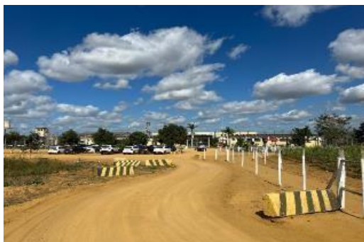
Foto 3: VIA DE TERRA DE ACESSO AO ESTACIONAMENTO EXTERNO DO CDRL ESQUERDA.
