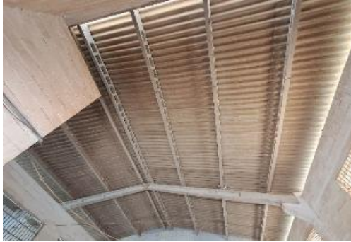
Foto 20: Imóvel vistoriado - COBERTURA INTERNA DO GALPÃO.
