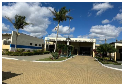
Foto 5: FACHADA PRINCIPAL DO CDRL.
