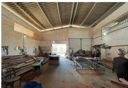
Foto 34: Imóvel vistoriado - OFICINA 1.
