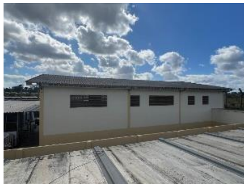
Foto 16: Imóvel vistoriado - LATERAL ESQUERDA
