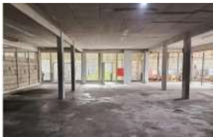
Figura 5 - Estado atual de conservação do "Pátio A"
