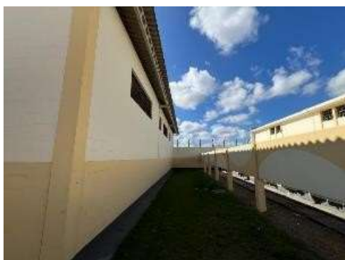
Foto 15: Imóvel vistoriado - LATERAL ESQUERDA.
