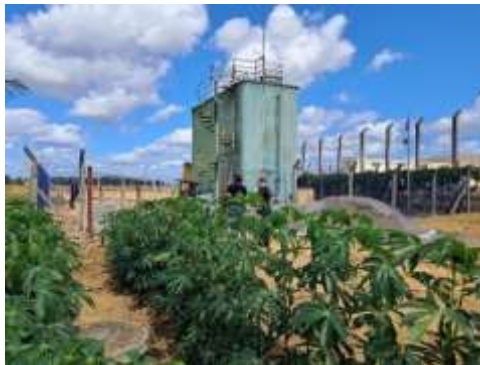
Foto 8: ESTAÇÃO DE TRATAMENTO DE ESGOTO.
