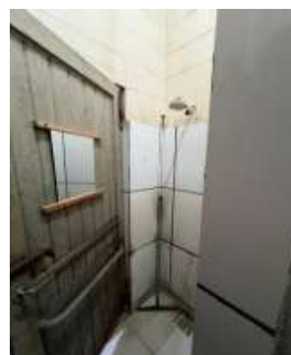
Foto 43: SANITÁRIO - BANHEIRO - OFICINA 1.
