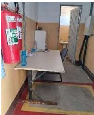
Foto 22: Imóvel vistoriado - SALA DE CONTROLE.
