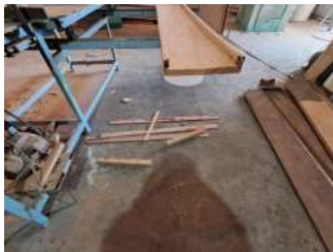
Foto 39: Imóvel vistoriado - PISO - OFICINA 1.
