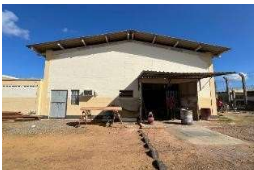
Foto 11: Imóvel vistoriado - FRENTE DO GALPÃO.
