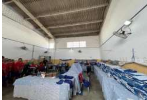
Foto 33: Imóvel vistoriado - COBERTURA - OFICINA 2.
