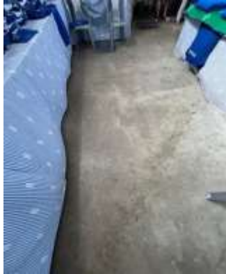
Foto 32: Imóvel vistoriado - PISO - OFICINA 2.
