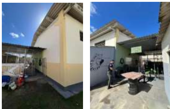
Foto 17 e 18: Imóvel vistoriado - FUNDOS DO GALPÃO
