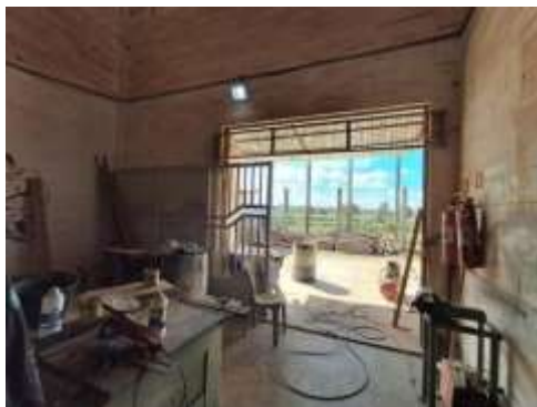
Foto 36: Imóvel vistoriado - PORTÃO DE ENTRADA - OFICINA 1.
