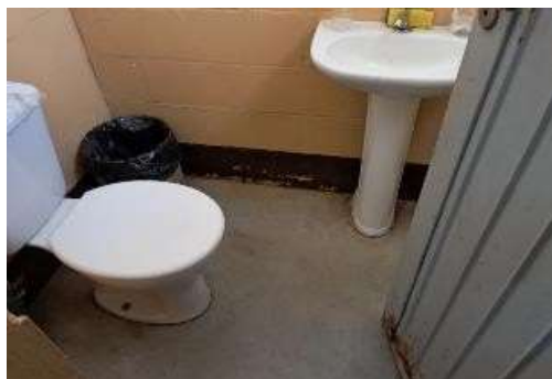
Foto 24: Imóvel vistoriado -BANHEIROS DA S. DE CONTROLE
