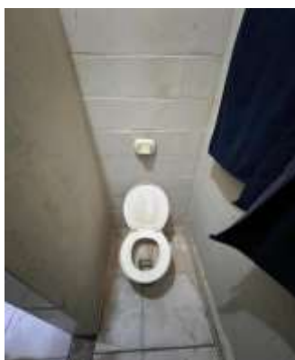
Foto 42: Imóvel vistoriado - BANHEIRO - OFICINA 1.
