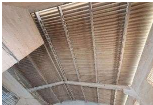
Foto 20: Imóvel vistoriado - COBERTURA INTERNA DO GALPÃO.
