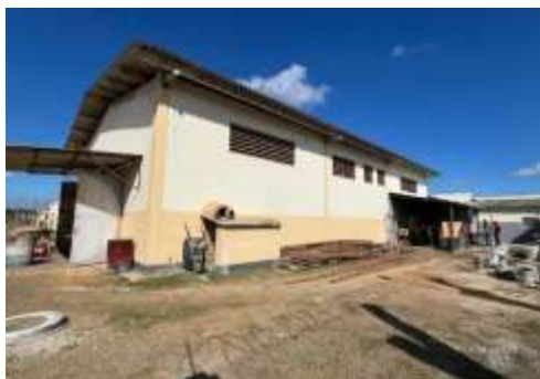
Foto 13: Imóvel vistoriado - LATERAL DIREITA
