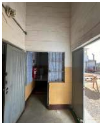
Foto 21: Imóvel vistoriado - CIRCULAÇÃO DE ENTRADA.
