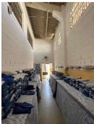
Foto 26: Imóvel vistoriado - CORREDOR DE ENTRADA DAS
