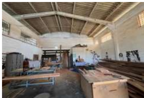
Foto 38: Imóvel vistoriado - OFICINA 1.
