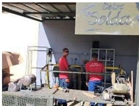
Foto 14: SETOR DE SOLDAS LOCALIZADO NA LATERAL DIREITA DO GALPÃO
