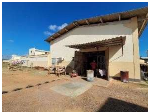
Foto 12: Imóvel vistoriado - FRENTE DO GALPÃO.
