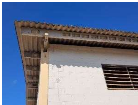
Foto 19: Imóvel vistoriado - DETALHE COBERTURA
