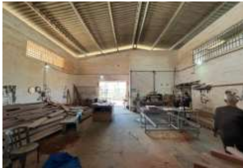
Foto 34: Imóvel vistoriado - OFICINA 1.
