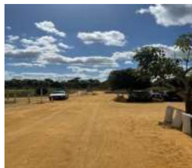
Foto 2: VIA DE TERRA DE ACESSO CDRL.
