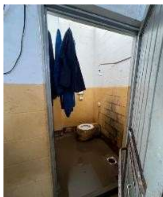
Foto 30: Banheiro - Imóvel vistoriado - OFICINA 2.
