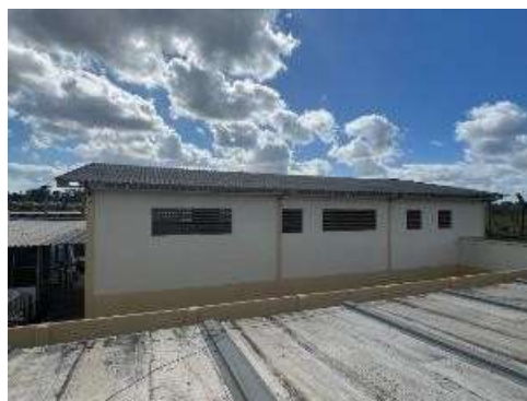
Foto 16: Imóvel vistoriado - LATERAL ESQUERDA
