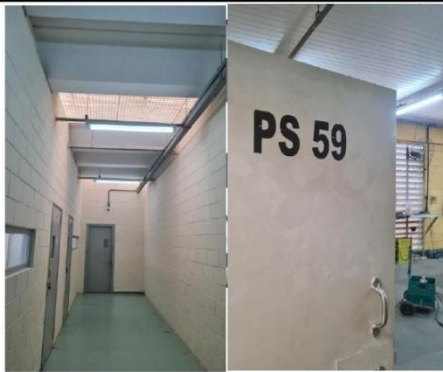
Foto 1: Hall de acesso a porta da oficina 02 - PS-59
