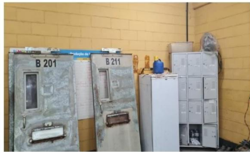
Foto 4: Oficina 02, sendo utilizada pela unidade PRCI.
