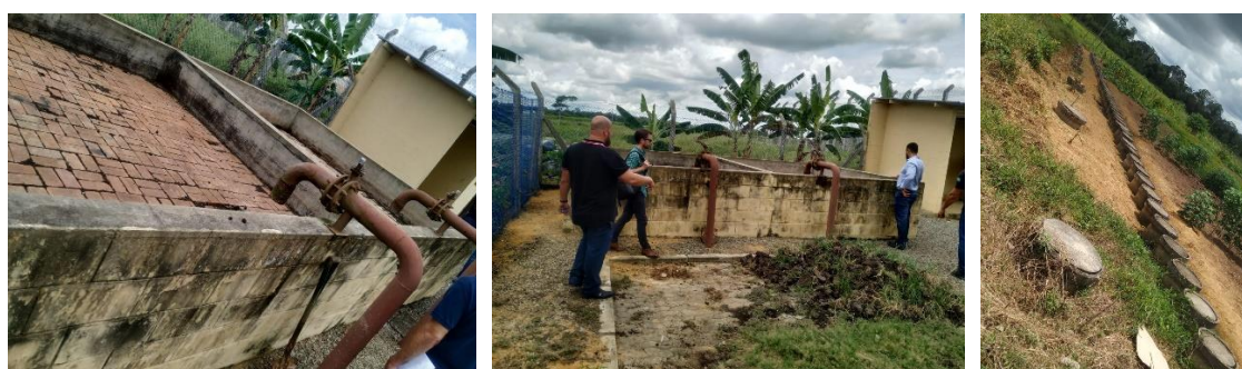
Figura 8. Estação de tratamento de esgoto e vala de infiltração do Centro de Detenção e Ressocialização de Linhares, próximo ao terreno da nova UP.
