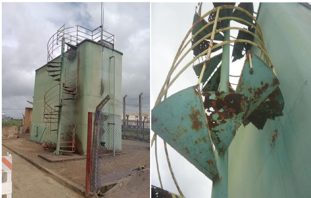
Figuras 6 e 7: Tanque de tratamento da ETE do CDRL e imagem aproximada da escada de acesso ao tanque
