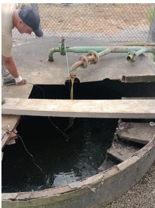
Figura 8: Estação Elevatória de Esgoto Bruto
