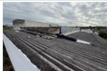
Figura 9 - Telhado existente da "ÁREA EM L"
