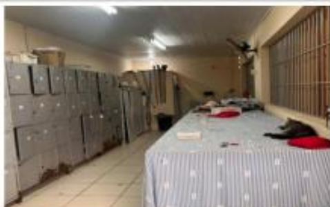
Figura 5 - Estado atual de conservação da "ÁREA EM L"
