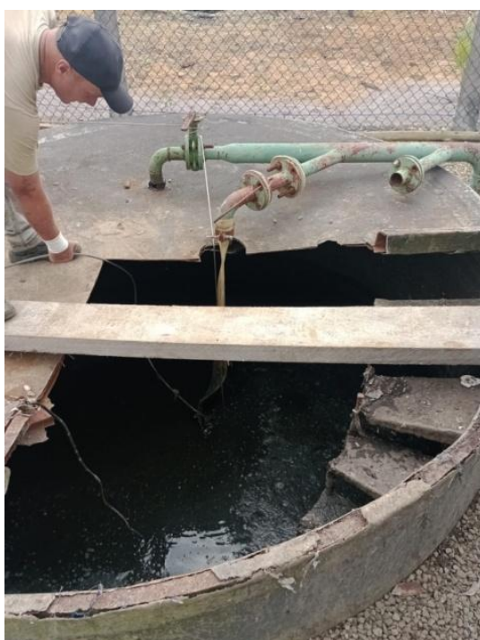
Figura 8: Estação Elevatória de Esgoto Bruto
